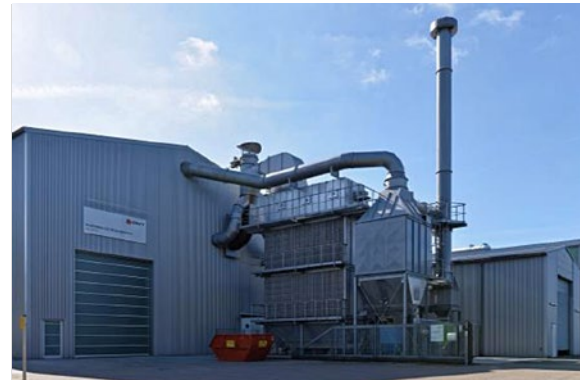
Neue Prüfhalle mit Rauchgasreinigungsanlage
