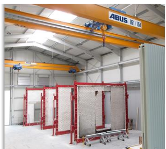
Neue Montagehalle mit vorgerichteten Stellplätzen
