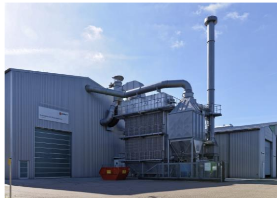
Neue Prüfhalle mit Rauchgasreinigungsanlage
