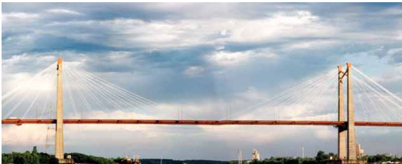
Brücke Rio Paraná, Argentinien
