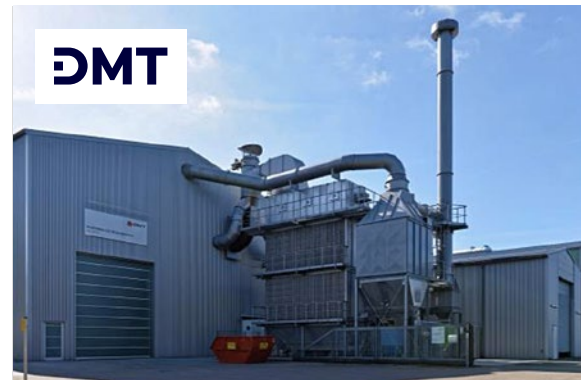
DMT Prüfczentrum in Lathen (Emsland)
