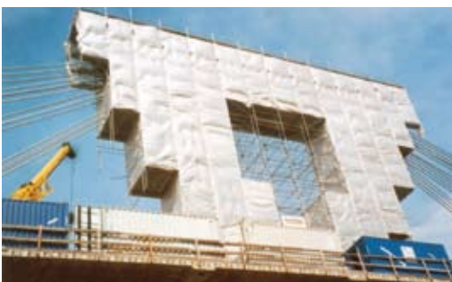
Pylon während der Bauphase, Rheinbrücke A44 bei Ilverich
