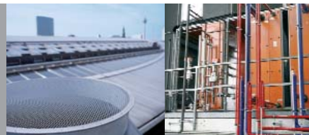
Untersuchung und Begutachtung der Anlagentechnik
